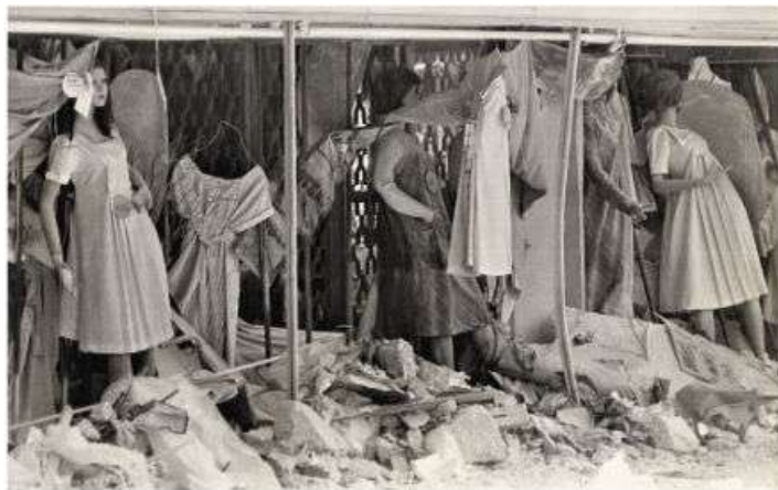
Figura 5.20 El 19 de septiembre de 1985 la Ciudad de México fue seriamente dañada tras el sismo y sus réplicas.
