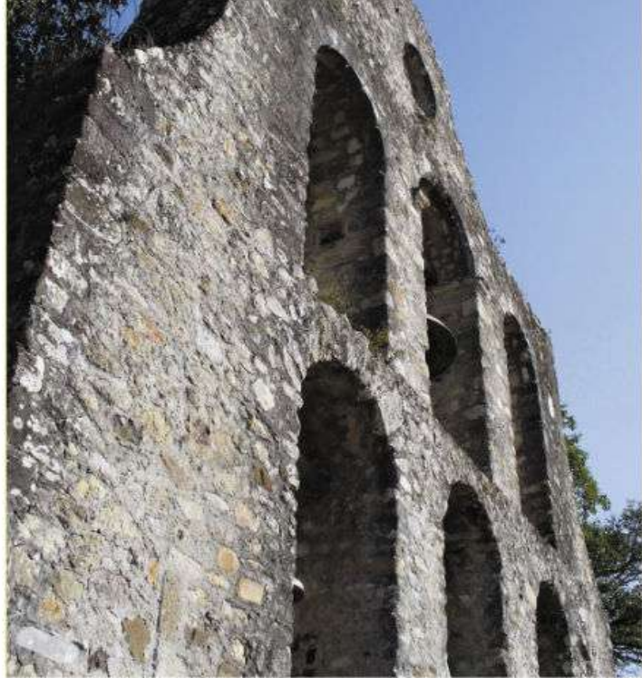
Figura 1.44 La espadaña es un elemento arquitectónico cuyo origen se encuentra en la arquitectura románica (siglos XI y XII), es una estructura que sirve para poner campanas. Convento de Molango, Hidalgo, siglo XVI.
